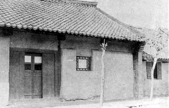
Mi casa de la calle Xiaonanmen, en Fusong.
